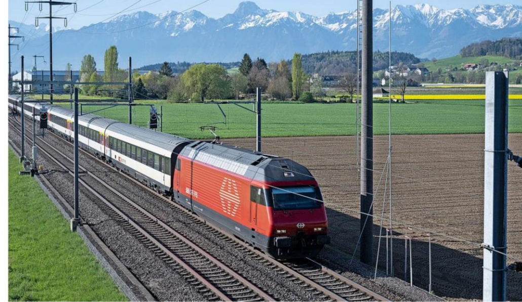
Wie die Profile zeigen, wird an diesem Standort in Wichtrach ein neuer Mast für die Funkanlage gebaut. Fotos: Raphael Moser
