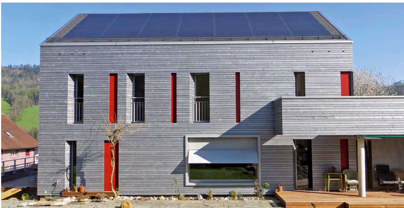
Eine umfassende Sanierung wie bei diesem Einfamilienhaus in Malter ist in der Regel nach 40 bis 50 Jahren nötig. Quelle: EnergieSchweiz
