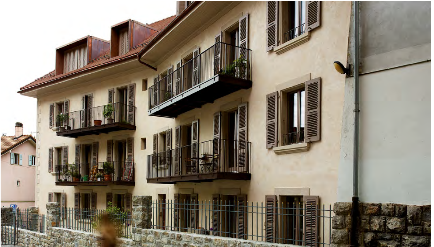
Bei diesem sanierten Gebäude in Lausanne sind die Balkone thermisch vom Gebäude getrennt und erzeugen so keine Wärmeverluste. Foto: Thomas Hensinger
